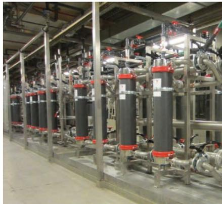
Beutelfiltergehäuse) und die Ultrafiltration (10 Stück UF-Endkappen-Module) aus einer Hand geliefert werden. Die notwendigen Umbaumaßnahmen erfolgen im Bestand („Brown
