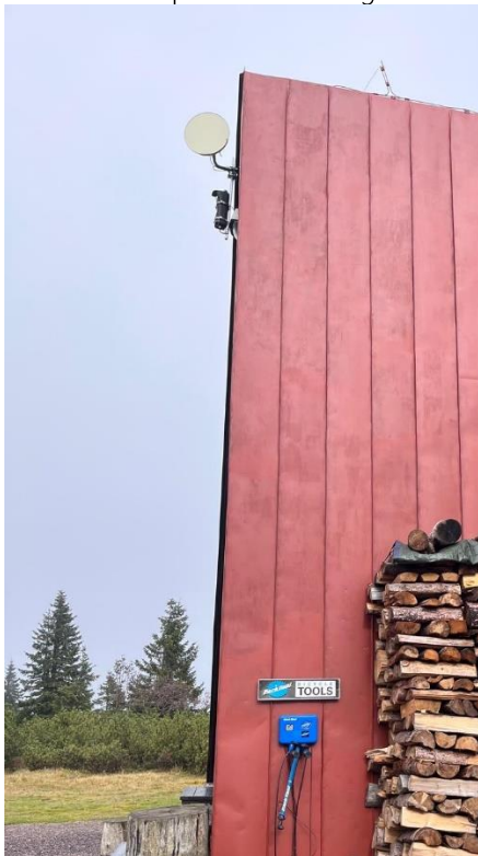
Der installierte Sensor in einem Gebäude des KRNAP – Nationalpark Riesengebirge.
